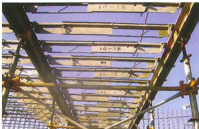
ビーム設置状況
