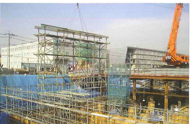
吊り込み状況
