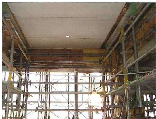
PCスラブ設置状況
