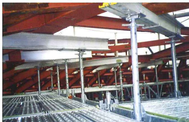
鉄骨受け状況
