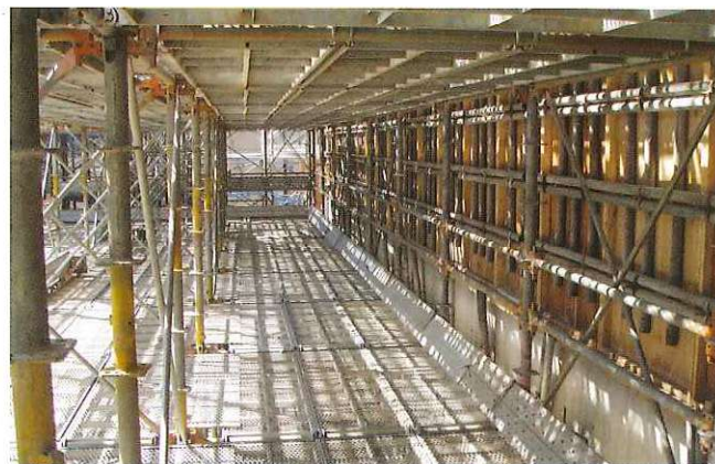
作業通路（壁側）
