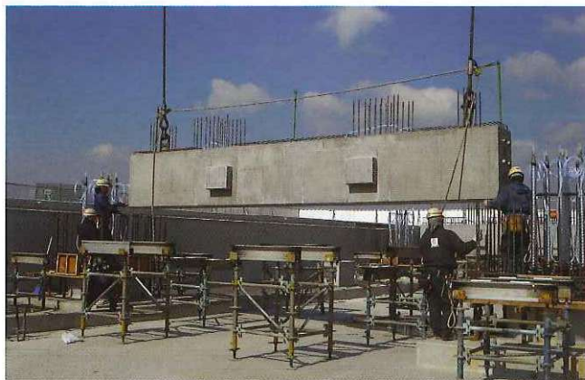
PC梁設置状況
