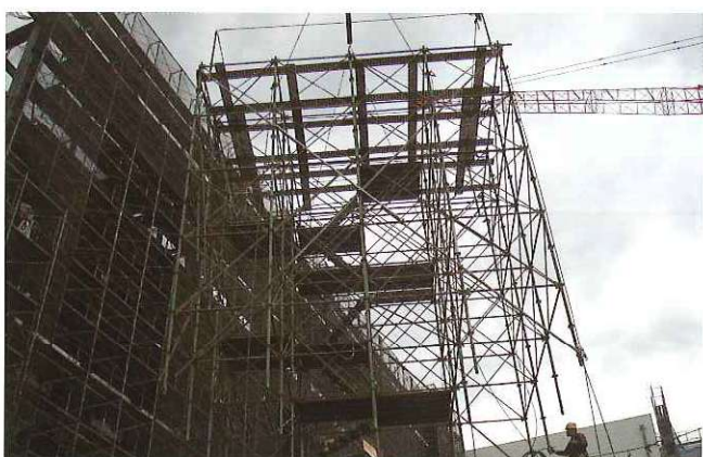
吊り込み状況
