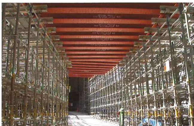
車路確保（H型鋼使用）
